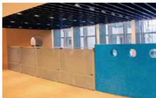
手すりとしての設置例 【葵の園・武蔵小杉】
