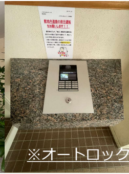
共用エントランス 管理人室
