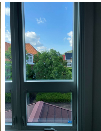
室内の窓は全てペアガラスに変更し、断熱性を高めました
