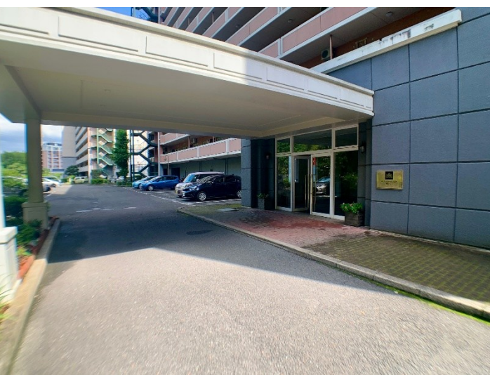
ヒルズⅠ 西側（エントランス側）
